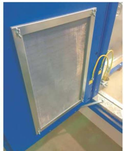
**Lüftungsgitter mit Schutzgrad IP43**
